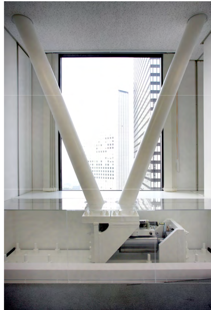
制震ダンパー設置状況
