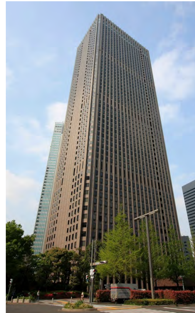
新宿センタービル
