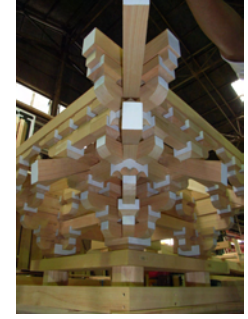
原寸図による軒先の反りの確認
