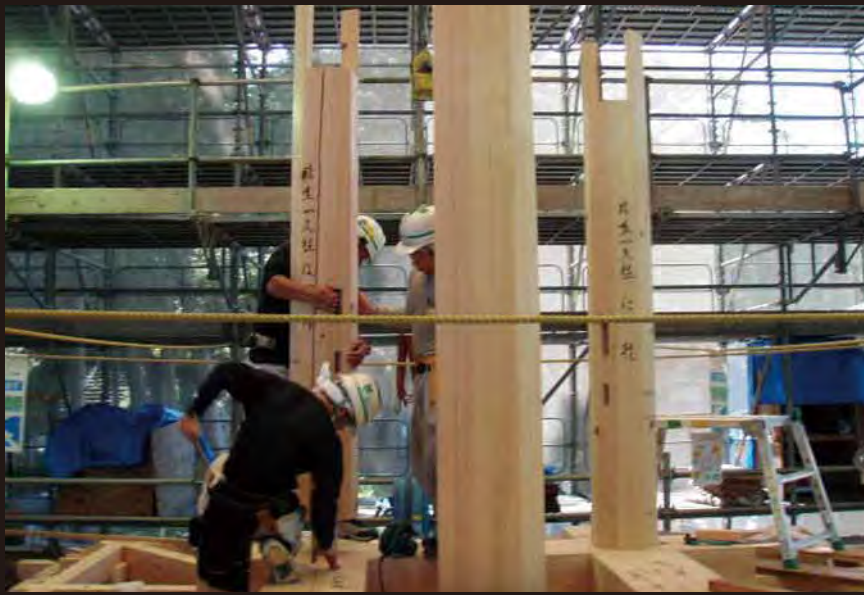
10 二重四天柱建て方
