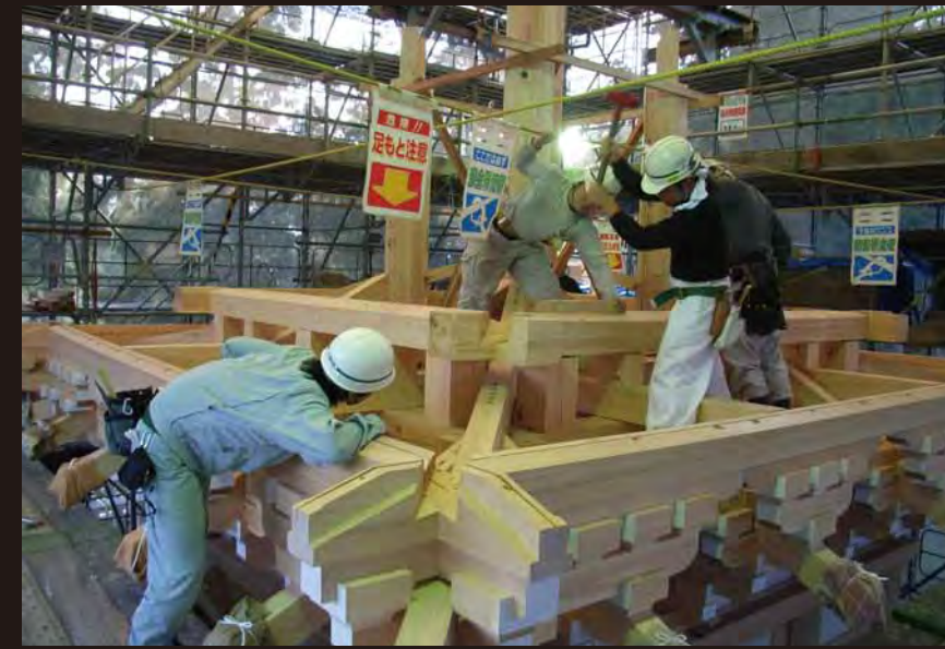
13 柱盤受け取付
