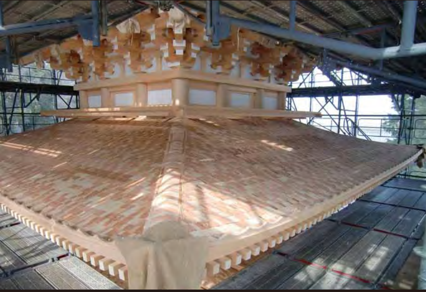
23 屋根下地土居葺
