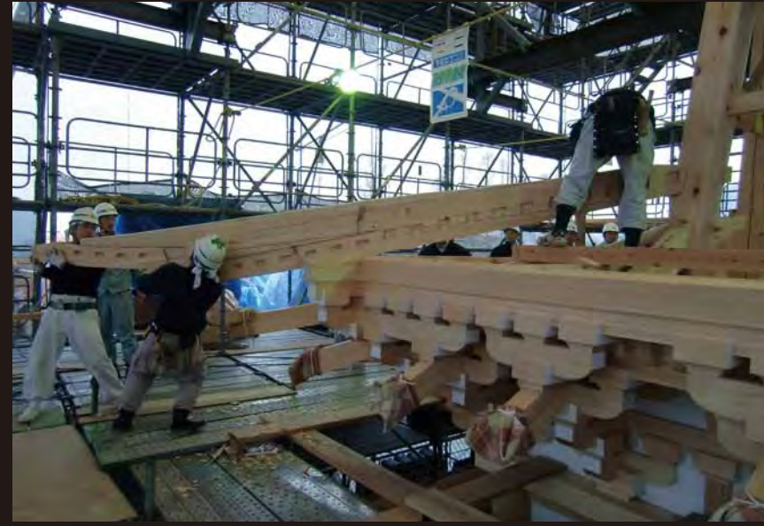
26 五重隅木取付
