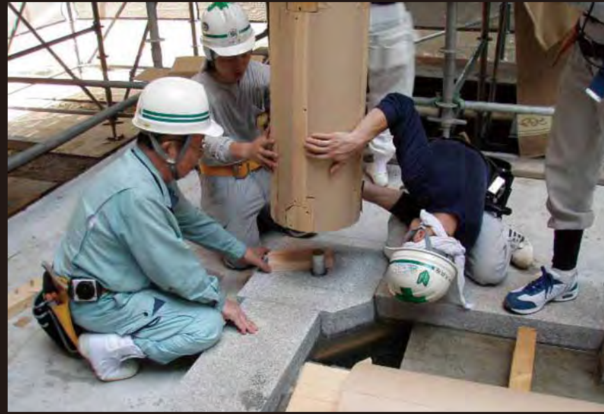
04 初重側柱建て方
