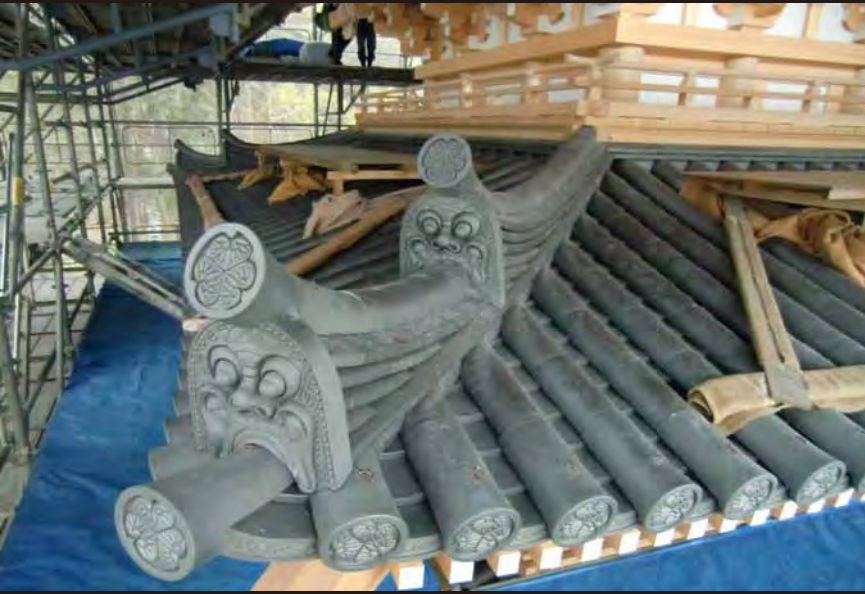
30 隅棟鬼瓦取付
