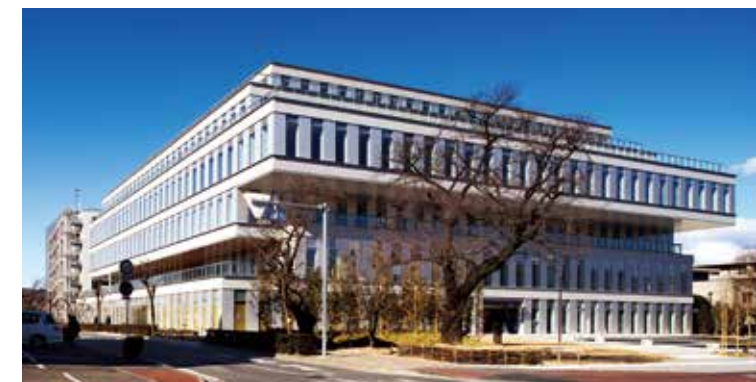
図4 高崎市総合保健センター・高崎市立中央図書館
