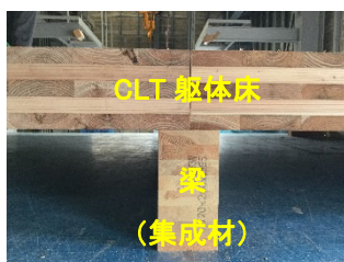
CLT 躯体床の断面
